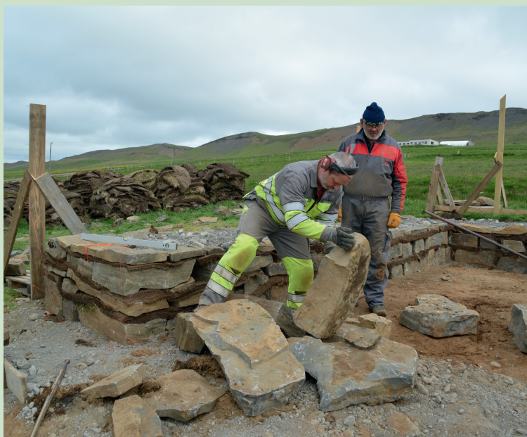
Basalt-Bruchstücke aus dem Nachbarfjord bilden das Fundament
