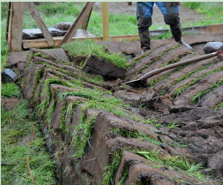
Dreiecksförmig gestochene Torfziegel bilden die Mauern.
