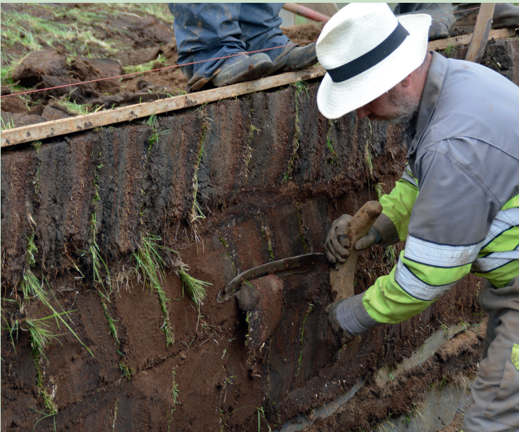
Torfbaumeister Helgi Sigurðsson beim Glätten der Wände
